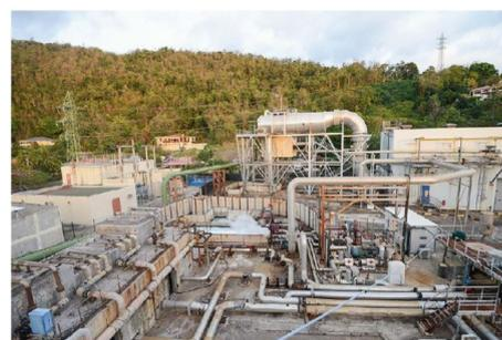
Ainsi, la centrale géothermique de Bouillante en Guadeloupe génère une puissance de 15 MW, ce qui permet de couvrir 7 à 8 % de la consommation de l'île.
